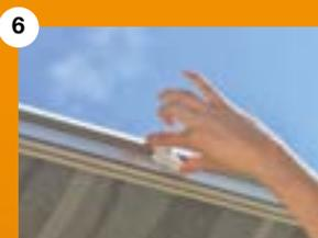
Il dispositivo di bloccaggio del profilo a incastro deve essere ruotato di un solo quarto di giro.
