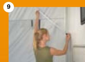
La controventatura aumenta la stabilità della struttura.
